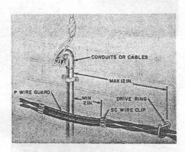
Fig. 14-Block Wire Crossing Over Conduit
